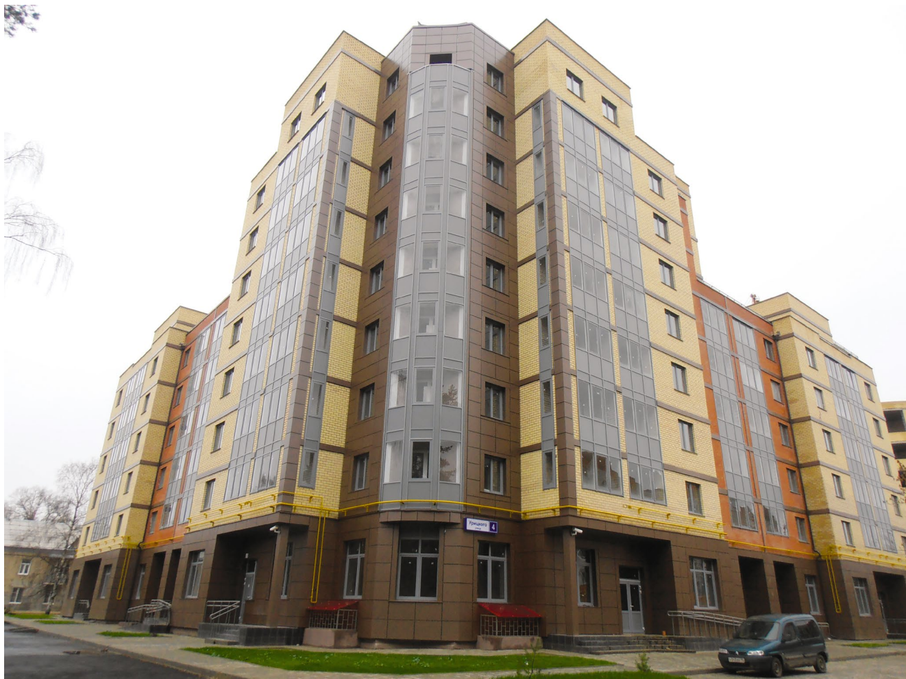
Объект: г. Дубна. Жилой комплекс Изготовитель конструкции: ООО «Бетиз ИК» Система: S50, F50
